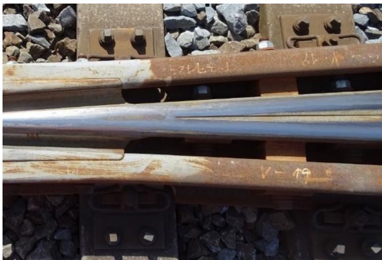
Obrázek 4 - Oblast hrotových kolejnic bez podélného svaru (výroba od roku 2019)
