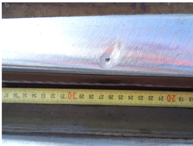
Obrázek 12 - Stav vady 511B po provedeném opravném broušení
