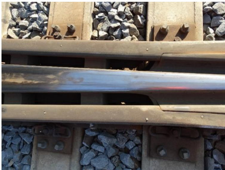
Obrázek 3 - Oblast hrotových kolejnic – s podélným svarem (výroba do roku 2018 včetně)
